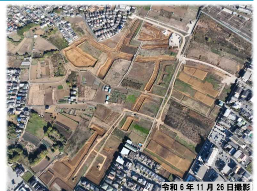
令和6年11月26日撮影 工事の進捗状況（ドローン撮影写真）
